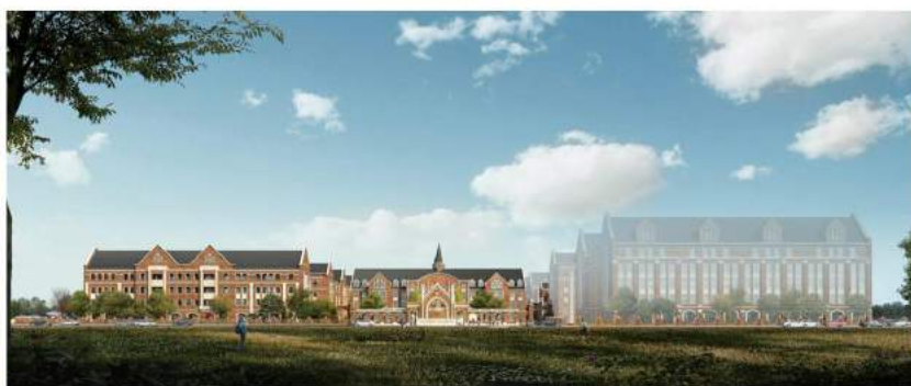
西渚幼儿园新建项目室内装饰工程
